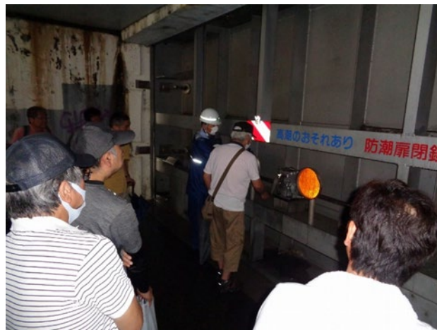
図 7-3-19 防潮扉 (*) の開閉訓練
