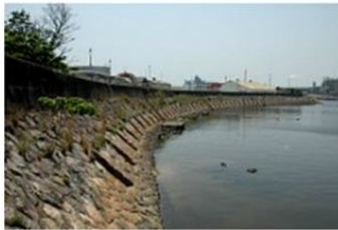
重要文化財・潮吹き防波堤
