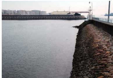
旧港西防波堤(右)と潮吹き防波堤(奥)
