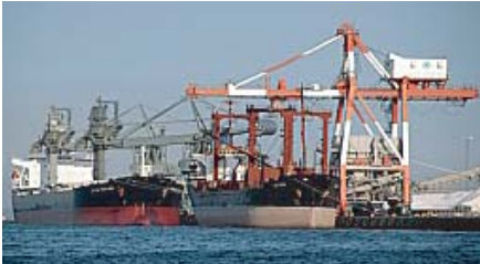
霞ヶ浦南埠頭22・23号岸壁で荷役中のバルク船
