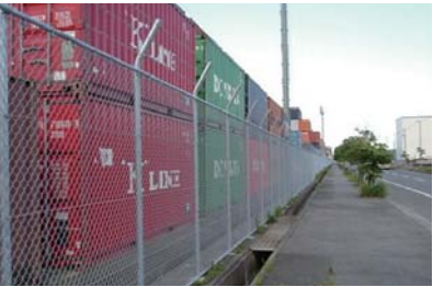
SOLAS条約によるフェンス
